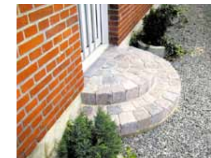
Trappeopbygning med Romerblokke
